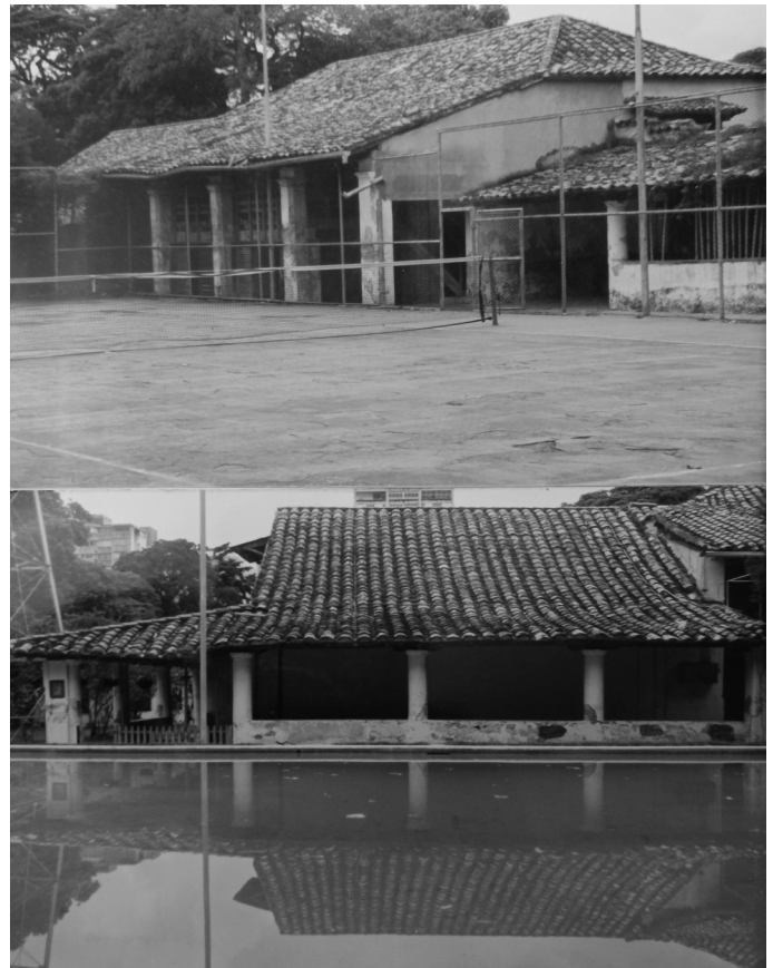
Figura 3. Cancha de tenis (superior) construida en el siglo XX sobre el patio de secado de café de La Floresta. Piscina construida con camellón sobre el patio otro de los patios de secado de la hacienda (inferior). (Fuente: Centro de documentación de PDVSA La Estancia).
