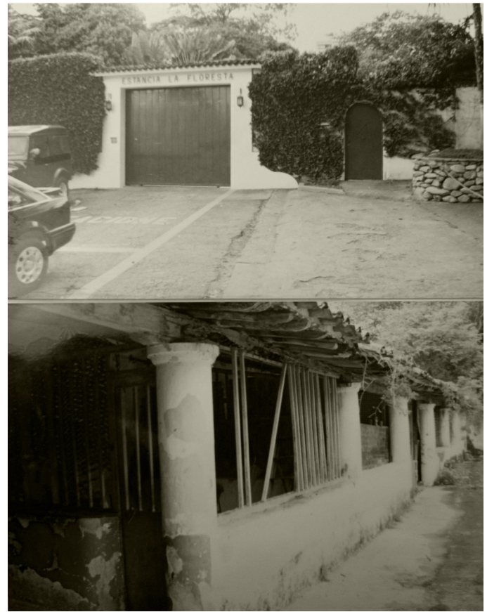
Figura 2. Acceso principal de La Estancia La Floresta hacia 1988 (superior). Estado en que se encontraba el inmueble (inferior), al momento de su adquisición por PDVSA en 1988. (Fuente: Centro de documentación de PDVSA La Estancia).
